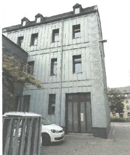
Abb.: Rückseite vom Haus Abb.: dichte Blechverkleidung von Giebel und Dach
