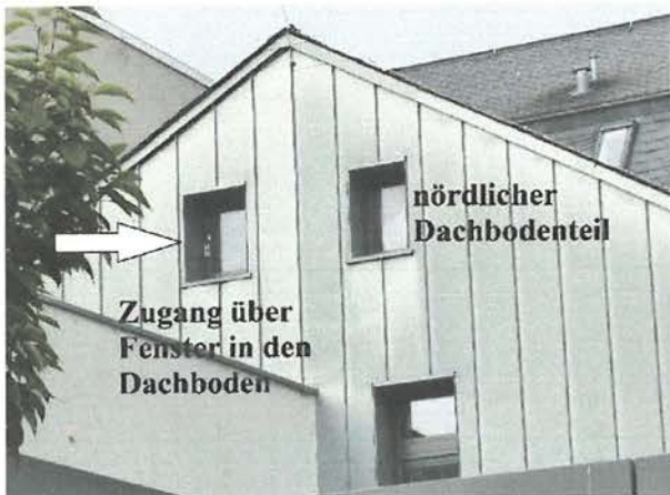
Abb.: mit Blech verkleideter Giebel Abb.: Dachbodenhälfte vom Fenster aus
