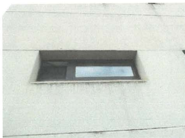
Abb.: dichte Fenstereinfassung
