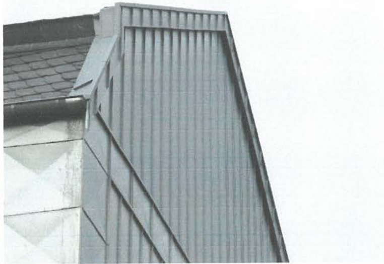
Abb.: Rückseite vom Haus Abb.: dichte Blechverkleidung von Giebel und Dach
