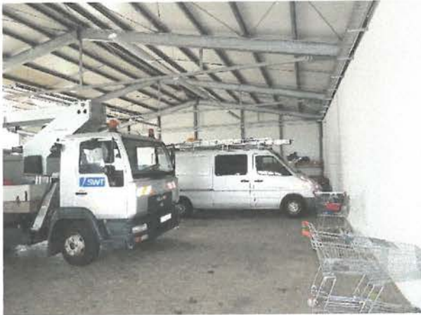
Abb.: Fahrzeuge in der Halle Abb.: Stahldachstuhl mit Sandwichplatten gedeckt
