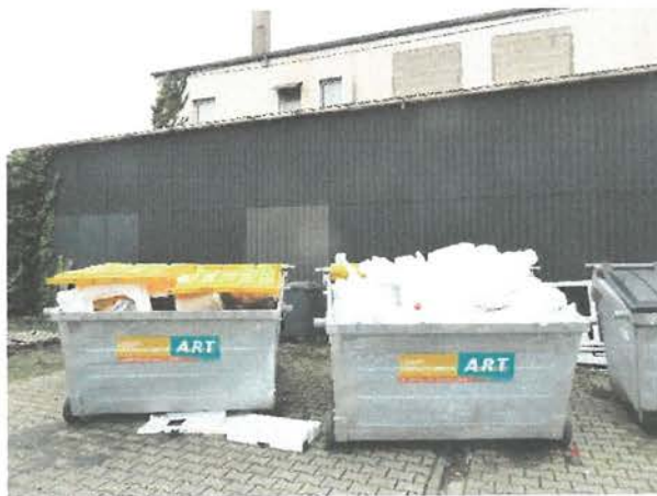
Abb.: mit Welleternit verkleidete Halle
