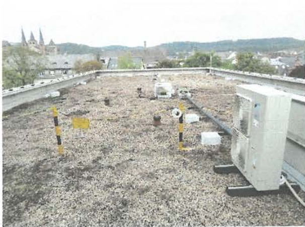
Abb.: Flachdach zur Ostallee hin Abb.: kaputte bzw. abstehende Abdeckung
