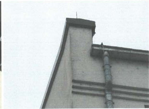
Abb.: ungeeignete Giebelabdeckung
