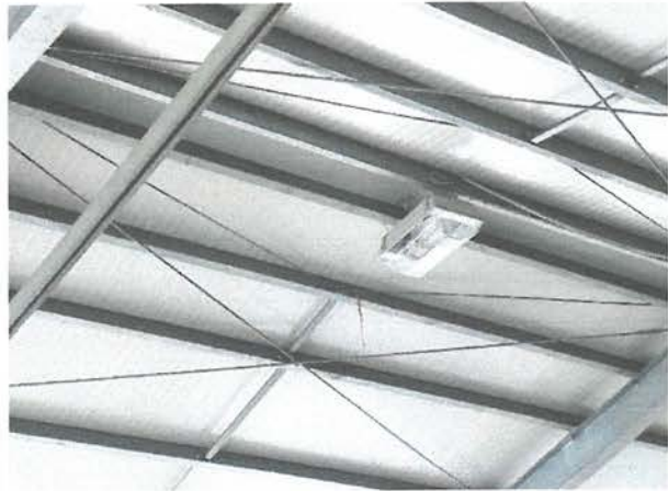
Abb.: Fahrzeuge in der Halle Abb.: Stahldachstuhl mit Sandwichplatten gedeckt
