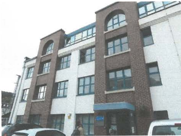
Abb.: verklinkerte Mauerbögen am Haus
