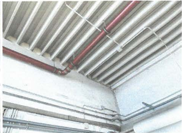
Abb.: mit Trapezblechen eingedeckte Halle
