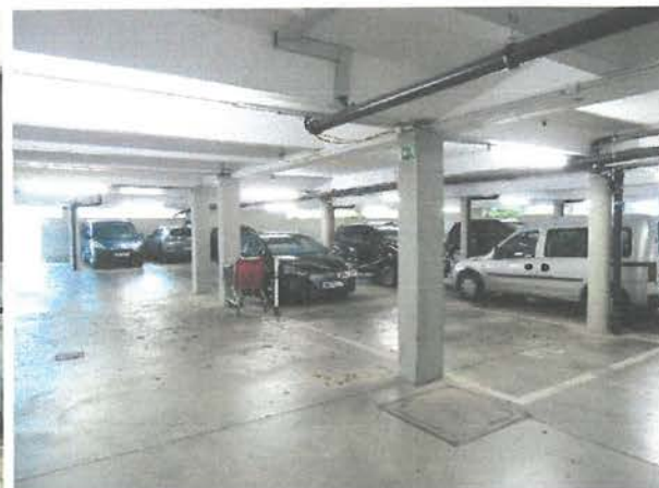
Abb.: Blick in die Tiefgarage
