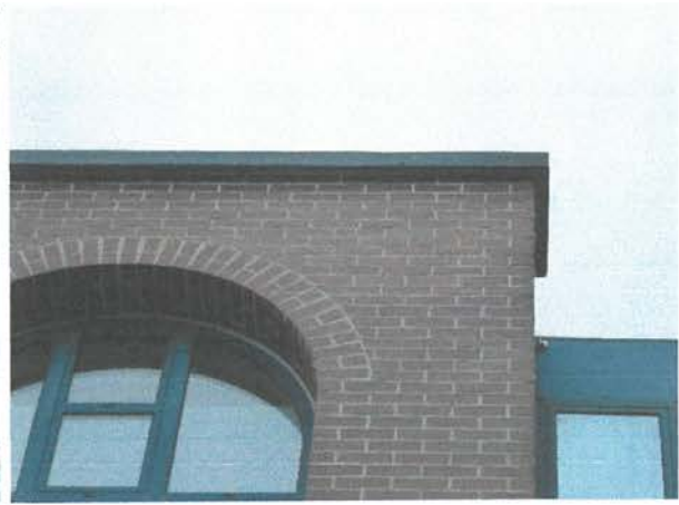
Abb.: Flachdachabdeckung auf Mauer
