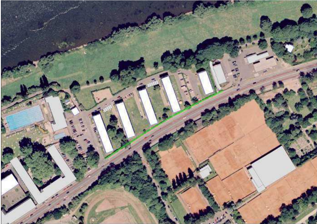
Abbildung 1: Lärmschutzwand Zurmaiener Straße
